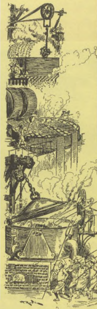
Внутри завода пицци
