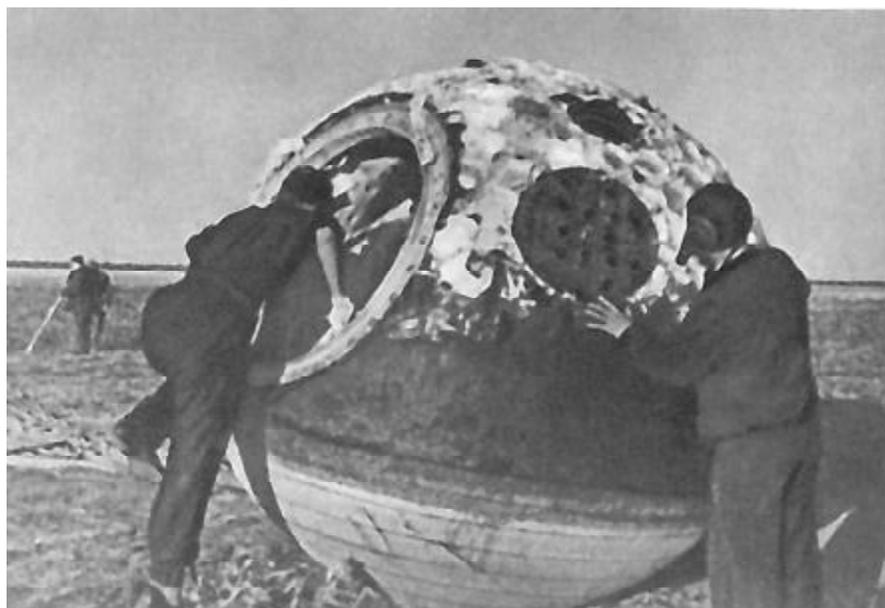
Рис. 108. Космический корабль «Восток» после благополучной посадки
