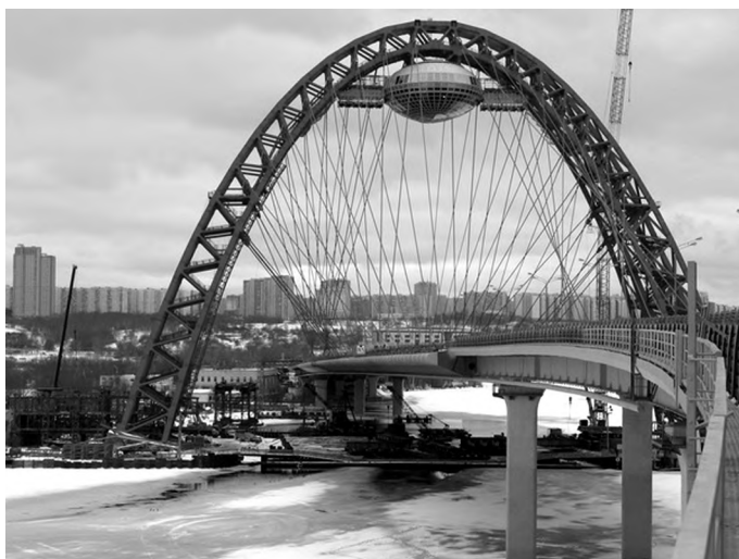
Первый в Москве вантовый мост «Живописный». Строительство и законченный мост, 2007 год
