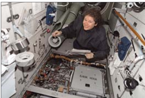
Сьюзен Хелмс меняет аккумуляторную батарею (блок 800А) в модуле «Заря»
