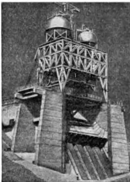
Открытый стенд в пустыне Мохаве (США) для огневых испытаний ЖРД Ф-1 (внизу, у газоотражателя, стоит человек)
