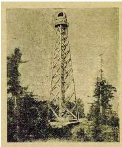
Башенный телескоп — прибор для изучения Солнца. Высота башни 45 метров.
