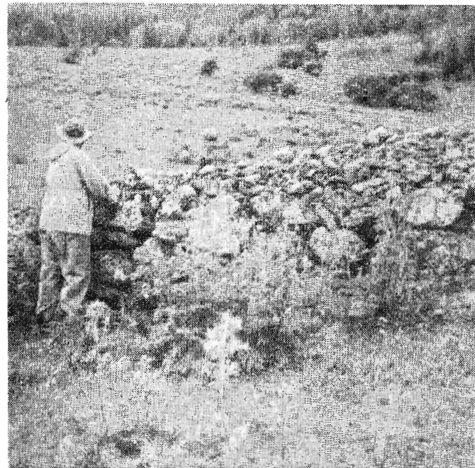
Рис. 19. Противолавинная отбойная дамба, построенная ала- нами на конусе выноса лавины (фото Г. К. Тушинского)
