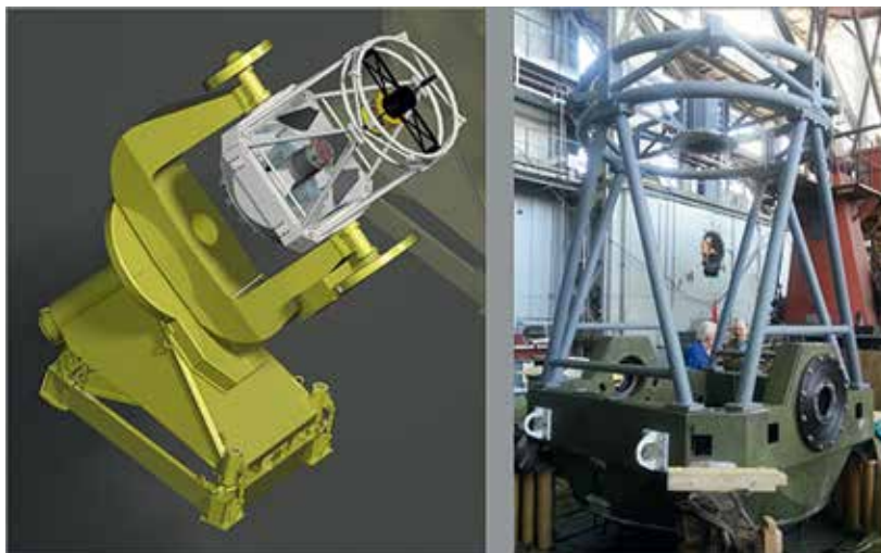
Рис. 3.23. Проект и рабочий момент строительства («ЛОМО») широкоугольного телескопа АЗТ-33ВМ
