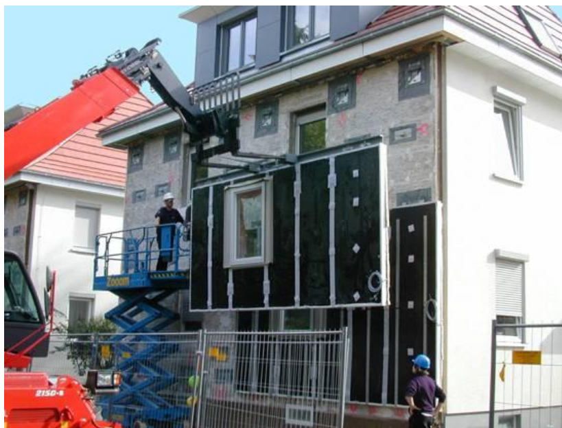
Рис. 1.13. Утепление здания вакуумными изоляционными панелями
