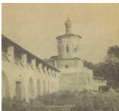
Толстые крепостные стены опоясывают Солотчинский кремль — замечательный памятник архитектуры XVII—XVIII веков. Справа — надвратная церковь, построенная по проекту крепостного зодчего Я. Г. Бухвостова
