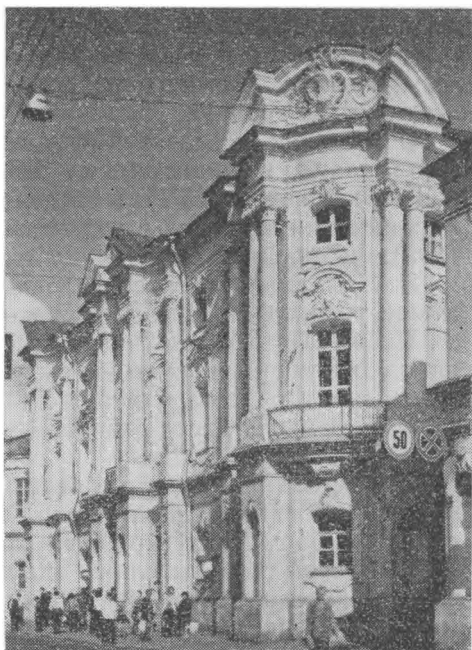
«Дом-комод» на улице Чернышевского
