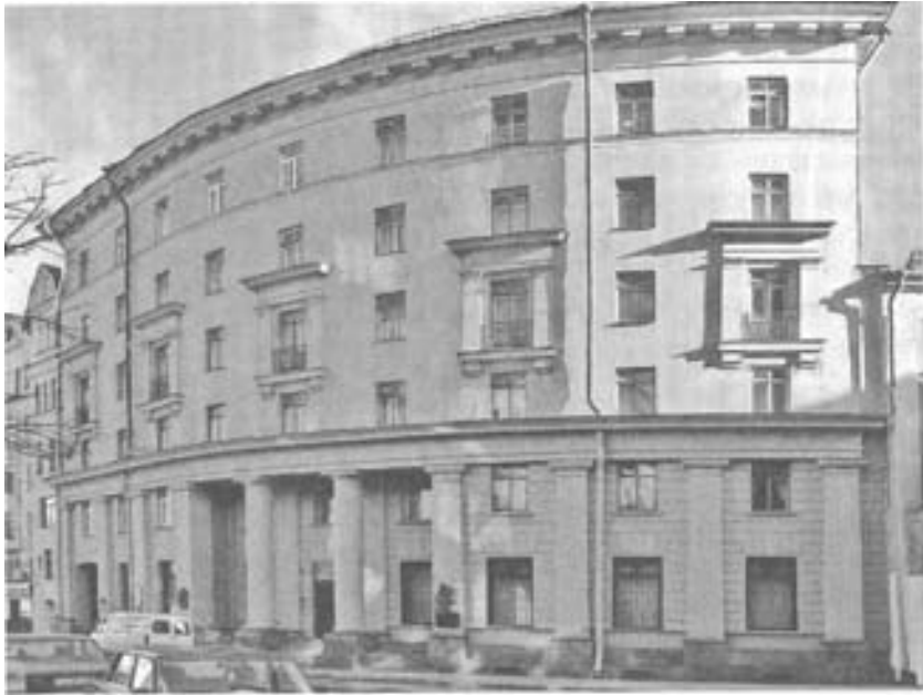
В этом доме жили М. А. Дудин, С. С. Орлов, Е. Л. Шварц (Малая Посадская ул., 8)
