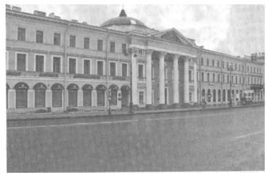
Здание Голландской церкви (Невский пр., 20)
