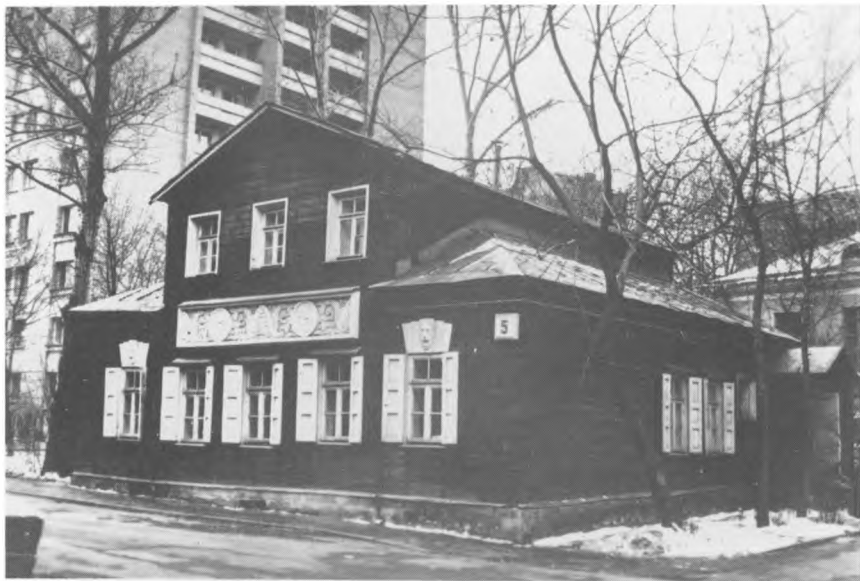
37. Улица Танеевых, 5. Деревянный особняк 1816 г., ампир. Образец послепожарной застройки Москвы.
