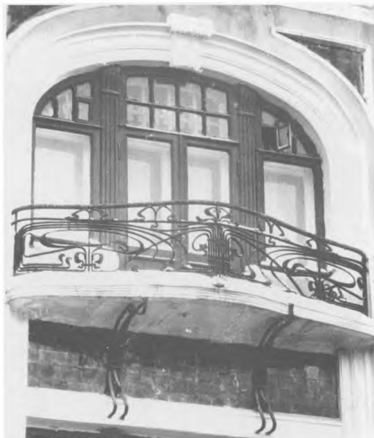
9. Арбат, 23. Ограждение балкона третьего этажа в стиле модерн.
