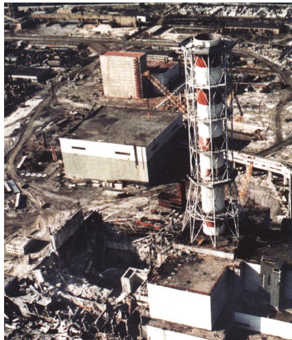
Авария на Чернобыльской АЭС
