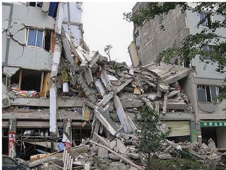
Рис 2.4. Дом, разрушенный землетрясением
