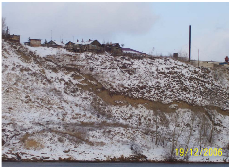
Рис. 4.10. Место схода оползня со зданием клуба деревобрабатывающего завода в протоку
