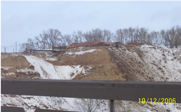
Рис. 4.4. Проведение противооползневых мероприятий на строительной площадке
