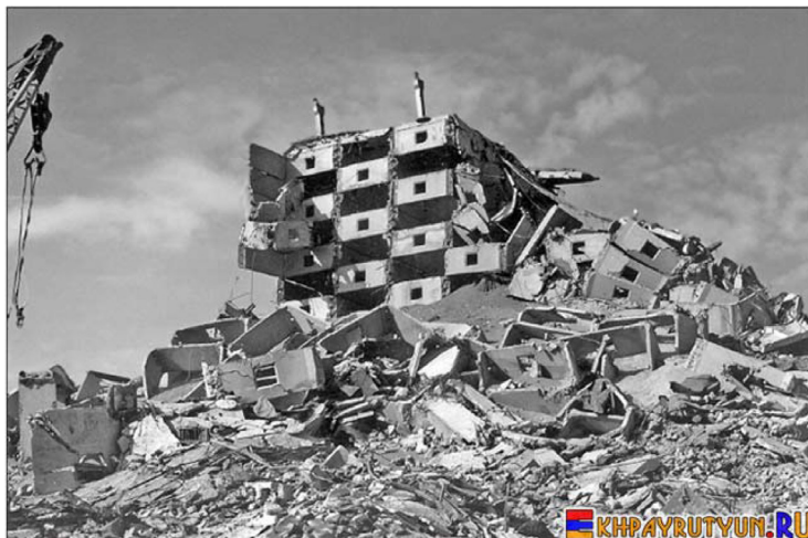
Рис. 2.2. Разрушения при землетрясении
