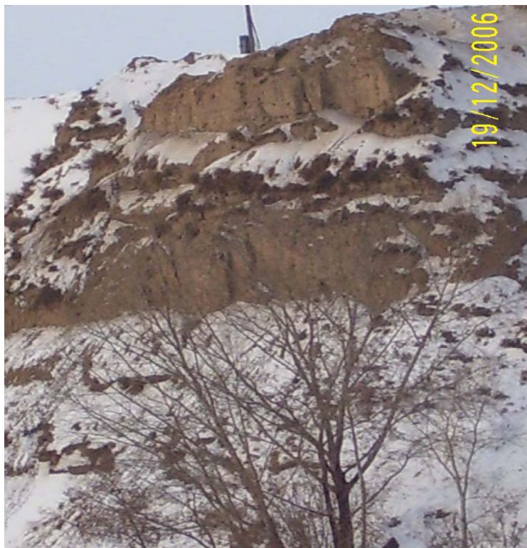
Рис. 4.9. Исходное положение строительной площадки ТРЦ «Июнь»
