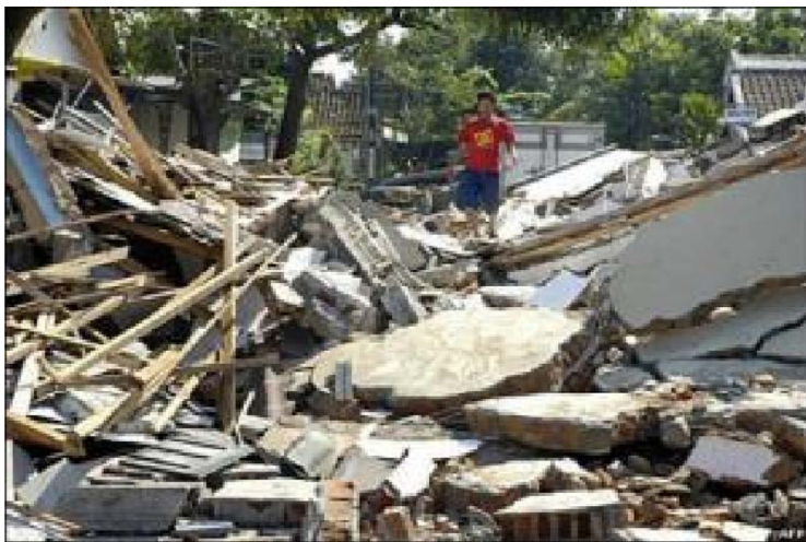
Рис. 2.3. Последствия землетрясения в Спитаке (Армения)
