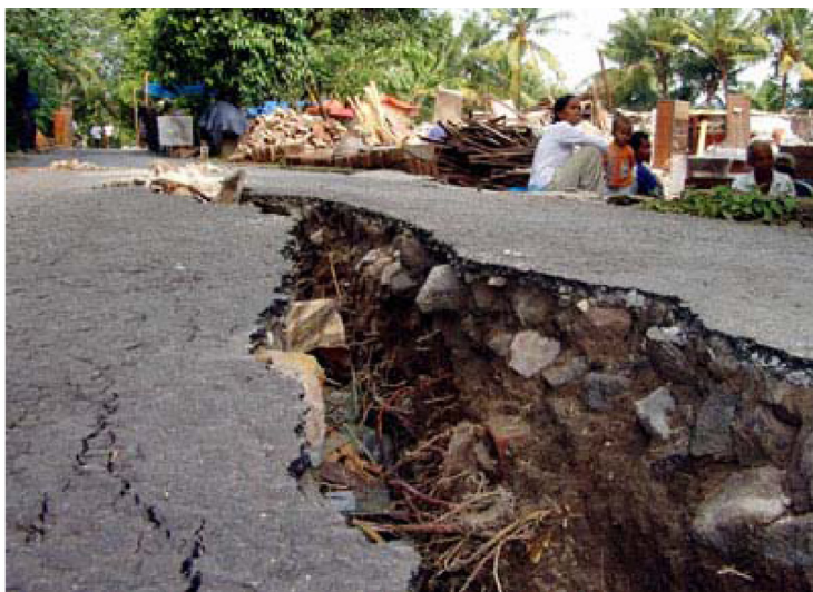
Рис. 2.5. Нарушение целостности земной поверхности
