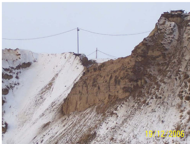
Рис. 4.11. Подготовка площадки для строительства торгово-развлекательного комплекса «Июнь»
