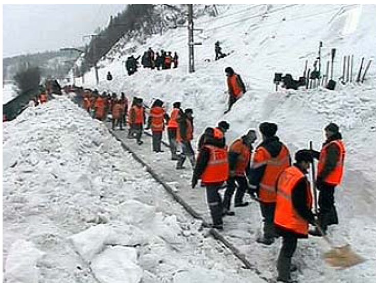
Рис. 4.27. Лавины сметают все на своем пути, повреждают и разрушают строения, коммуникации, ЛЭП, спортивные сооружения, дороги технику
