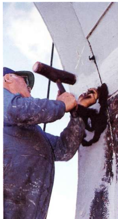
Швы между деревянными планками конопатят, чтобы они не пропускали воду
