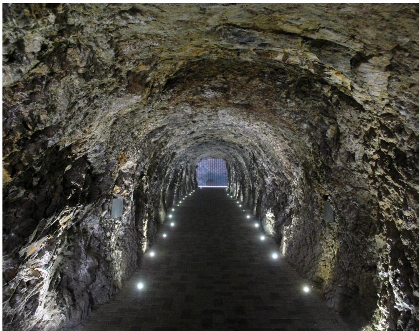
Рис. 12. Тоннель к озеру Провал
