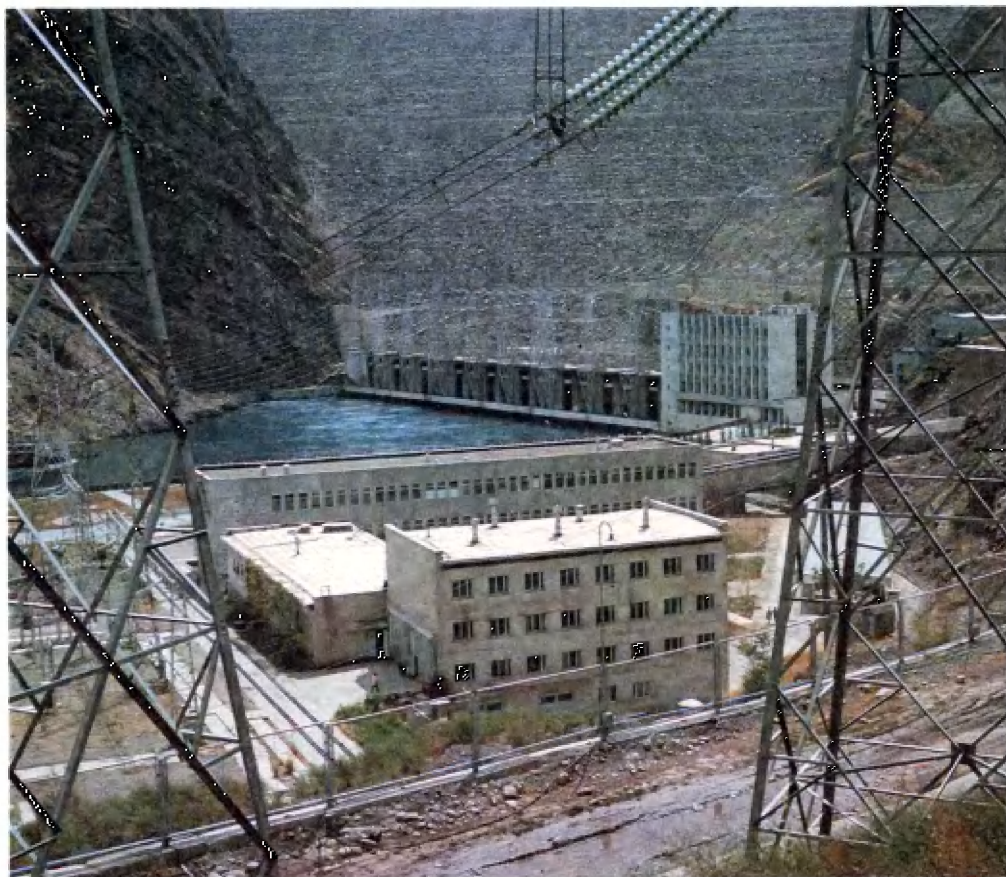
Здание и плотина Нурекской ГЭС.
