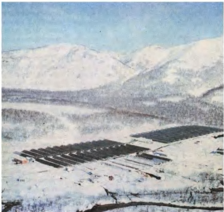
Теплицы совхоза «Термальный» обогревает тепло Мугновской скважины.
