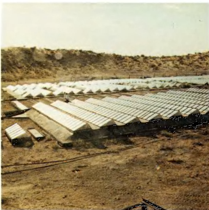
Совхозная опреснительная установка.
