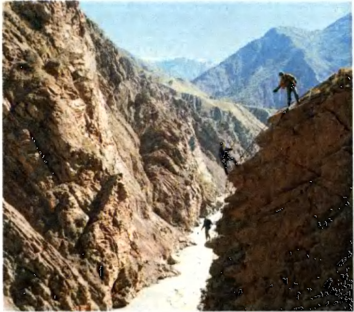
Скалолазы-монтажники на строительстве Рогунской ГЭС.
