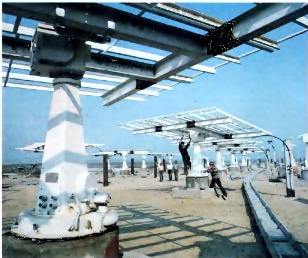
Монтаж гелиостатов Крымской солнечной электростанции.
