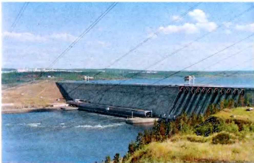
Плотина Усть-Илимской ГЭС.
