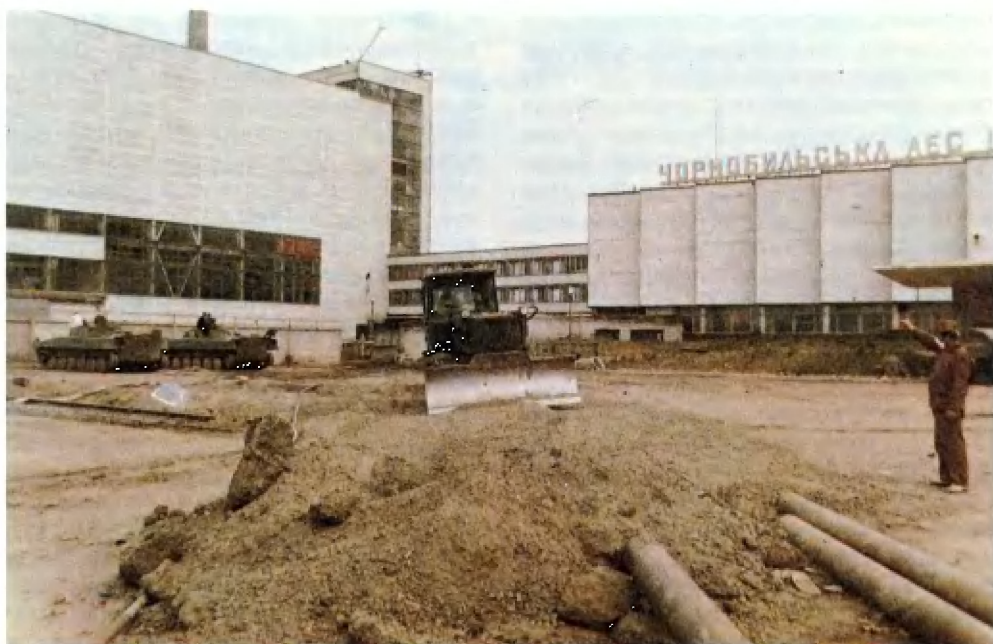
Восстановительные работы на территории Чернобыльской АЭС.
