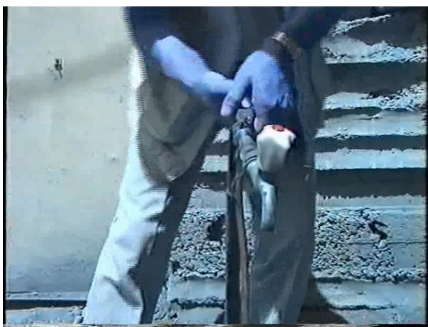
Рис. 6. Использование водопровода в качестве заземления
