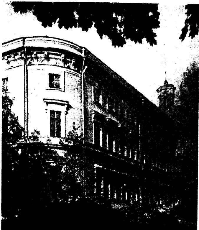
Инженерный замок. Угловое окно «круглой каморы» во втором этаже
