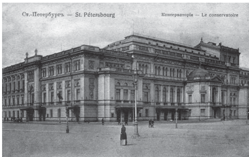
Санкт-Петербургская консерватория Открытие начала XX в.
