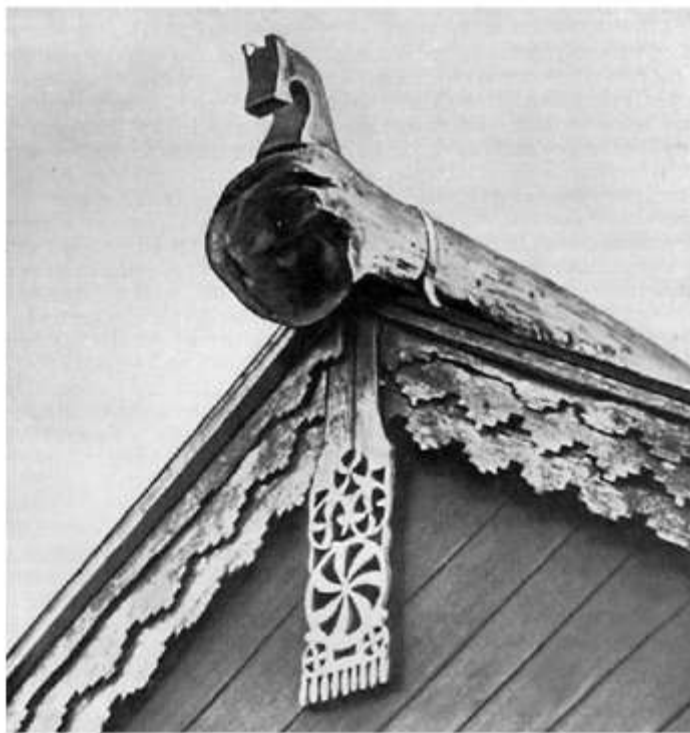
«ГРОМОВЫЙ ЗНАК» ПОД КОНЬКОМ КРЫШИ. Север
