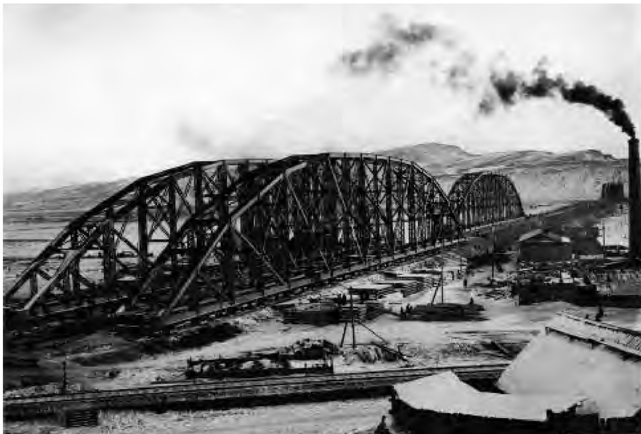
Строительство моста через р. Енисей. Фото 1899 г.
