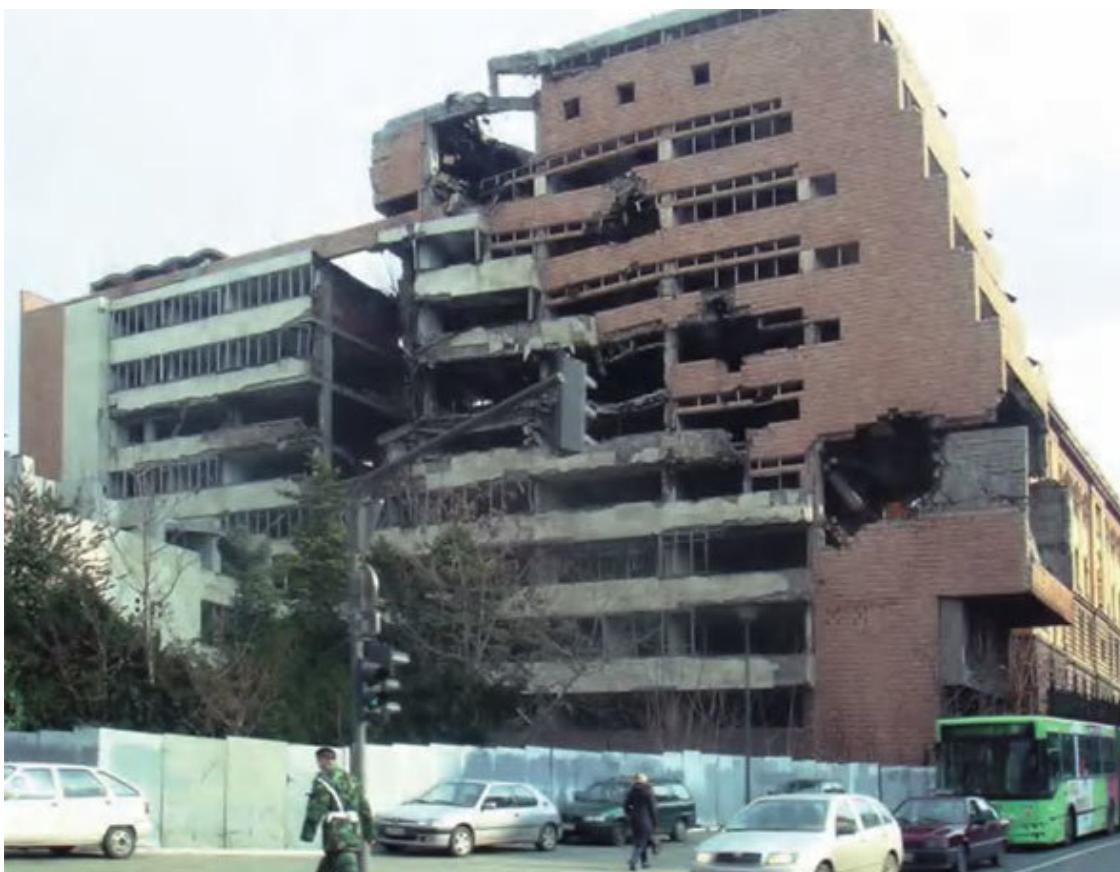
Разрушенные здания Министерства обороны в Белграде
