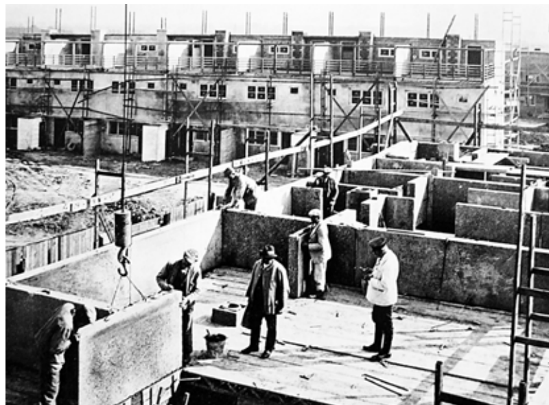
Рис. 9. Монтаж домов из крупных пемзобетонных плит
