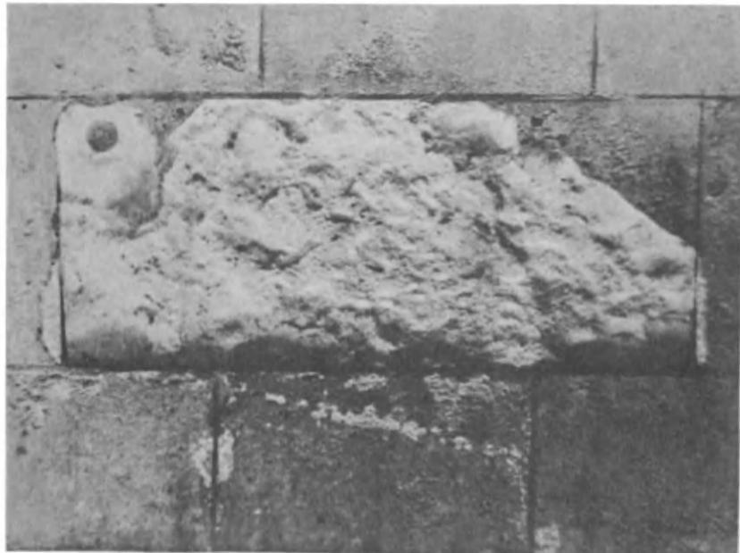
**Рис. 36. Разрушение верхней поверхности блока мячковского известняка на северной стене Успенского собора в Московском Кремле**
