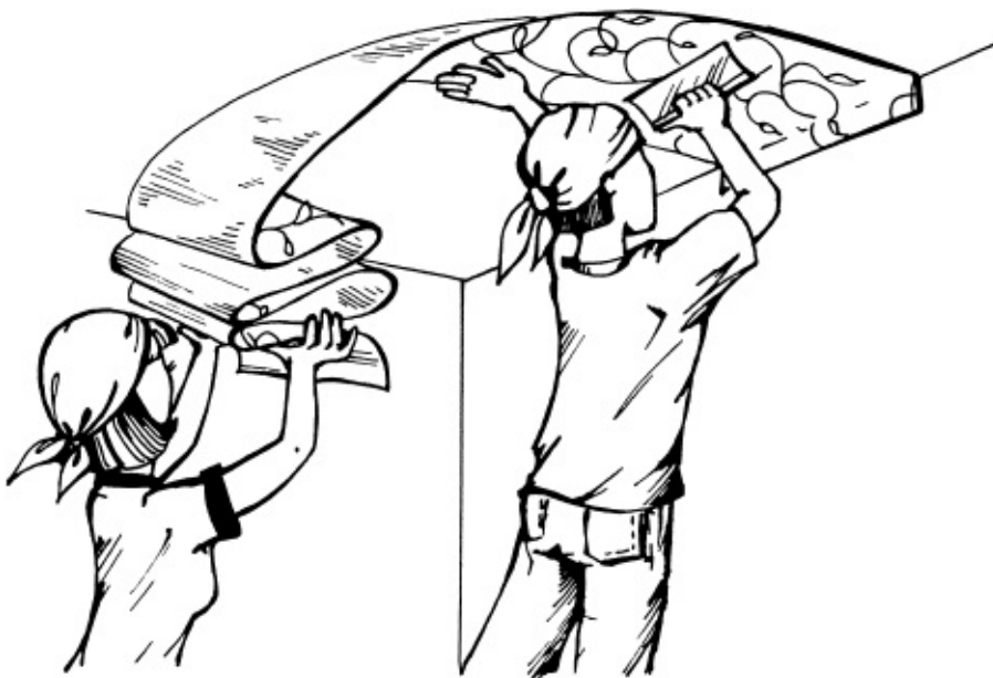
Рис. 15. Наклеивание потолочных обоев вдвоем
