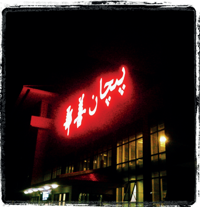
Рис. 53 Здание железнодорожного вокзала.
