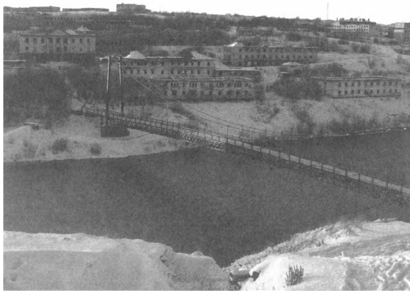
Фото 4. Современный вид на Рудник со стороны населенного района Воркуты - разрушенные геофизические здания, мост
