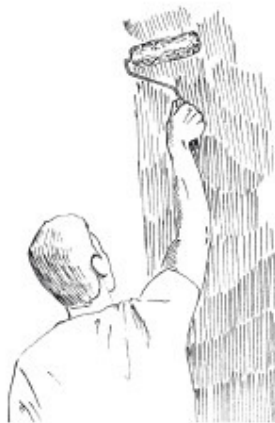
Рис. 62. Нанесение краски на стену с помощью валика
