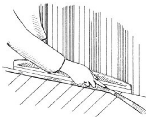
Рис. 76. Выравнивание низа обоев
