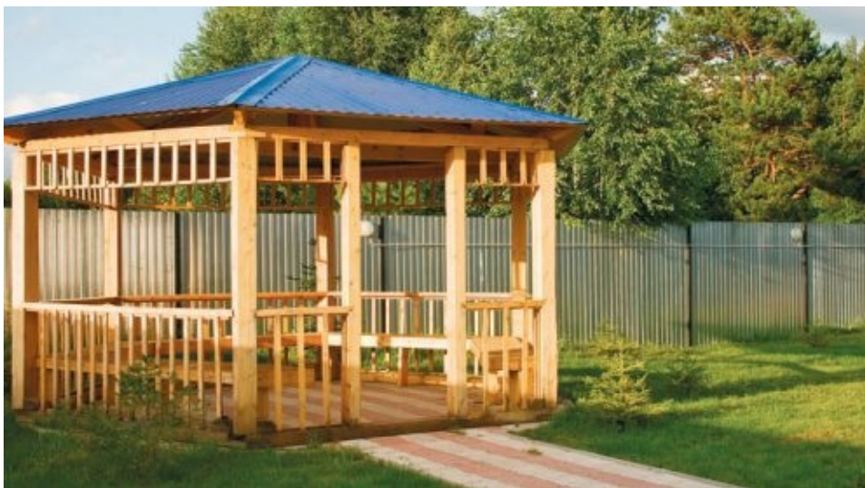
Рис. 9.15. Беседка с возведенными стенами
