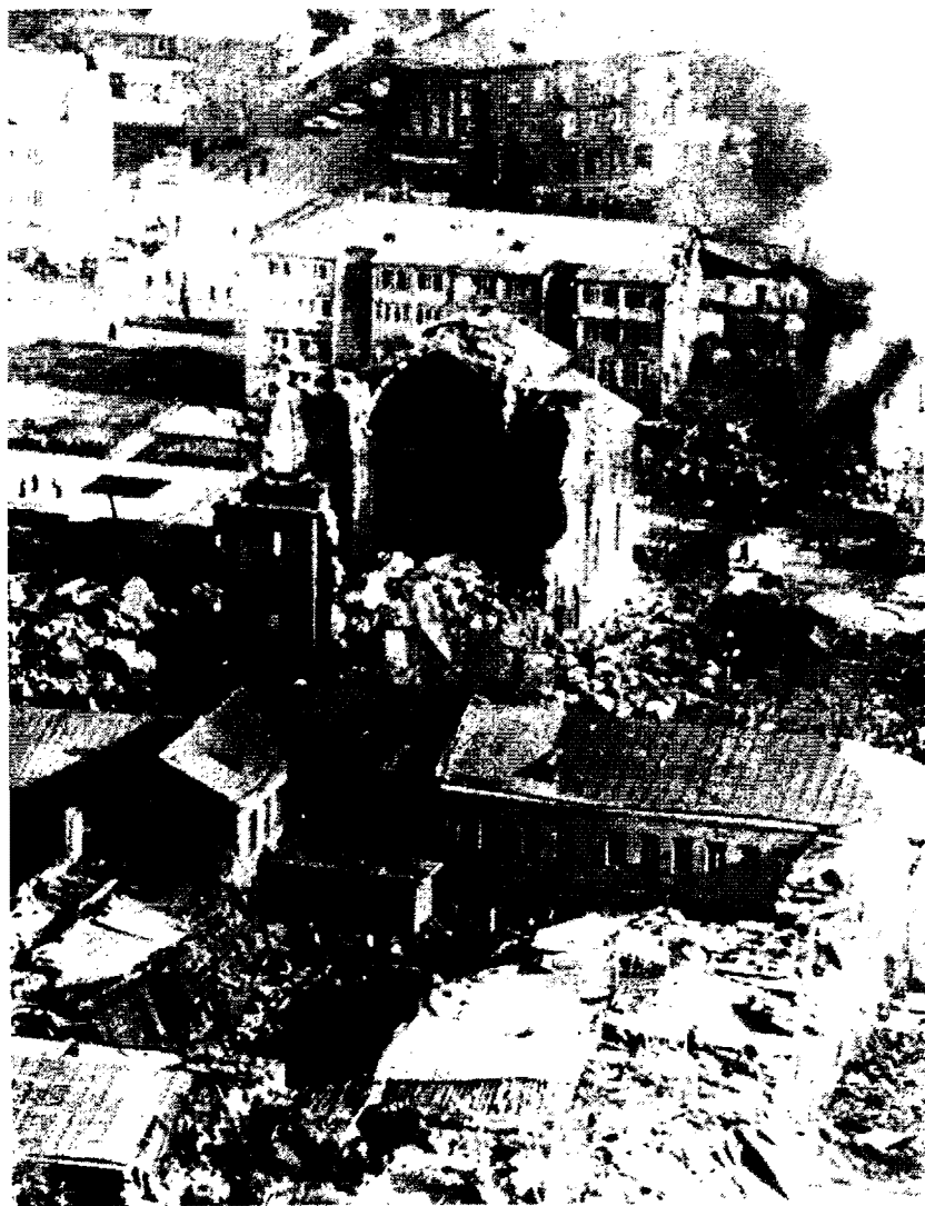
Спитакское землетрясение 7 декабря 1988 г. Разрушение зданий в г. Ленинакане.
