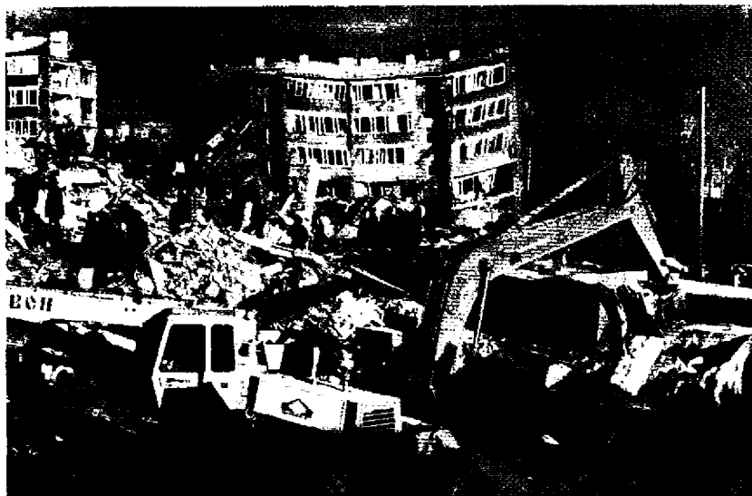
Разрушения после землетрясения (г. Слитак, 1988 г.)
