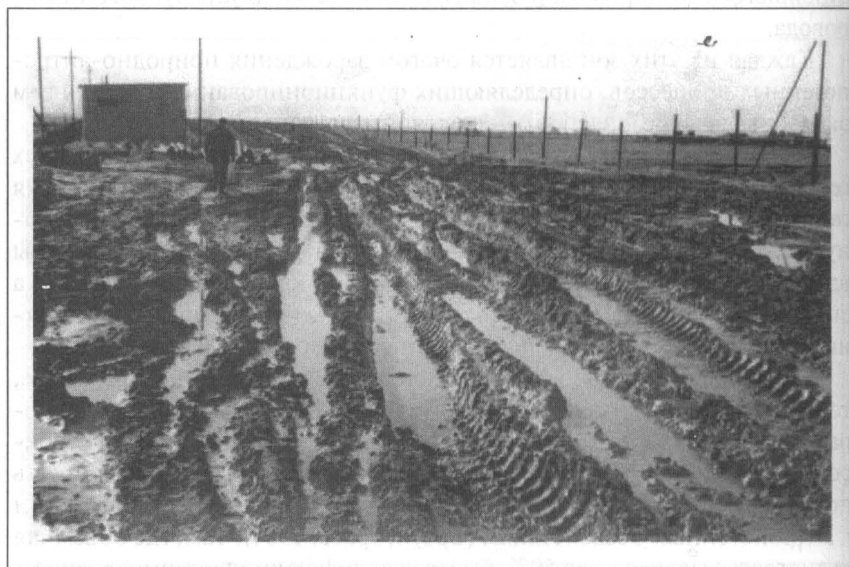
Рис. 15. Разжижение мерзлых грунтов под воздействием транспортных средств на насыпи автомобильной дороги с образованием обводненных колеи. Фото В.И. Евдокимова
