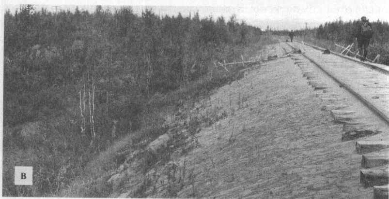
Рис. 9. Типы деформаций железнодорожного полотна «мертвой дороги» восточнее г. Салехарда: а — термокарстовый тип; б — искривление полотна в результате процессов пучения и термокарста; в — эоловые процессы на откосе насыпи. Фото В.Л. Суходровского
