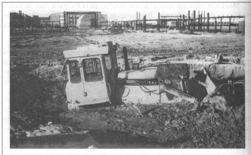
Рис. 14. Грунтам Ямала свойственно быстрое разжижение при обводнении и механическом воздействии (Бованенковское ГКМ). Фото В.И. Евдокимова
