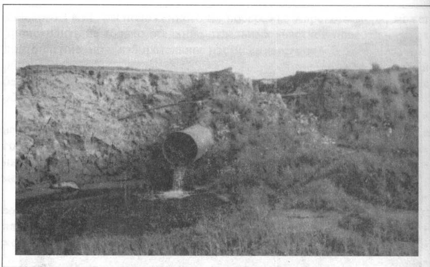
Рис. 12. Вдоль водопропускной трубы, пересекающей насыпь, обязательно закладывается промоина. Фото В.И. Евдокимова
