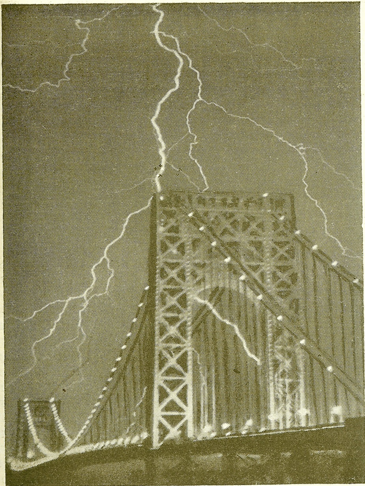
Линейная молния. Разряд направлен в цепной мост.
