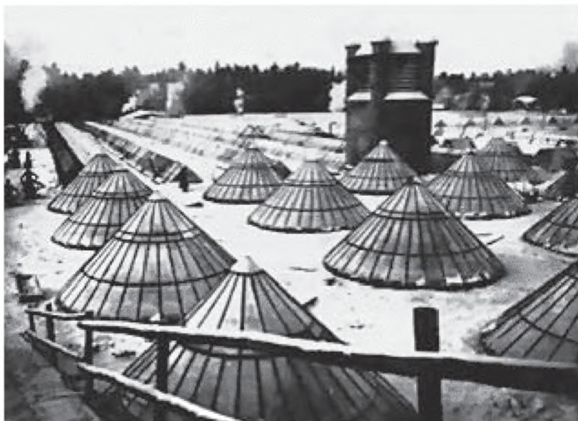
Световые стеклянные фонари на крыше Новоткацкой фабрики.
