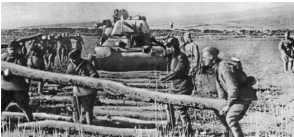
Саперы укладывают настил для прохода танков. Апрель 1944 г.
