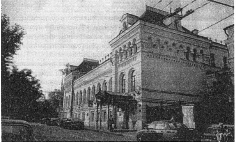
Москва, Гоголевский бульвар, 6. Здание Разведывательного управления Красной Армии
