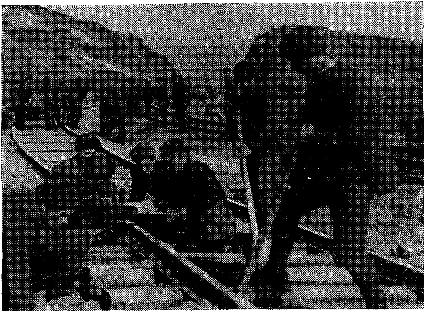
Строительство железнодорожных путей в полосе наступления Центрального фронта
