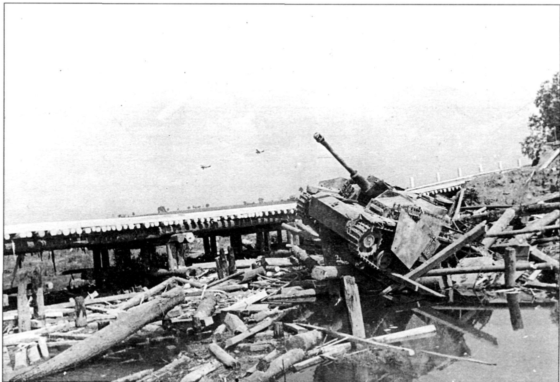
Штурмовое орудие, оставшееся на мосту, разрушенном советской авиацией. 1944 г.
