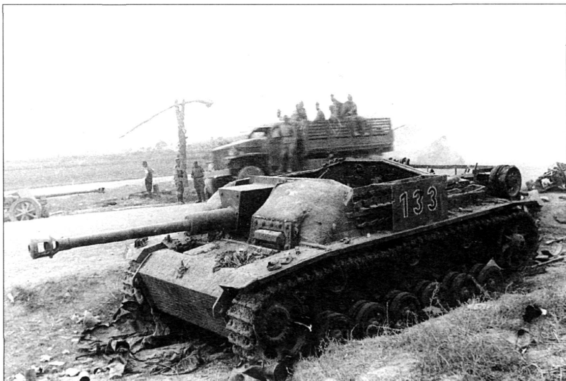
Подбитое в Румынии штурмовое орудие с толстым слоем цементной обзки. 1944 г.
