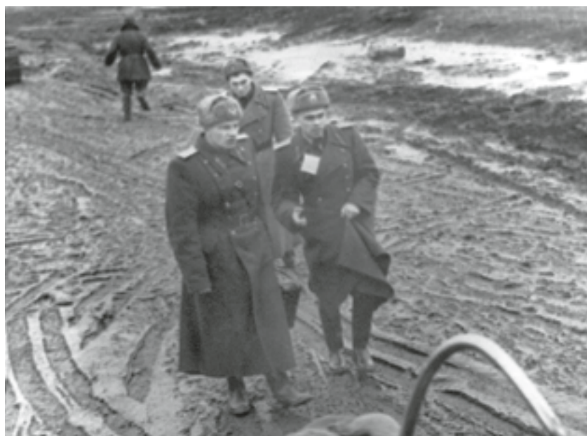
На месте возведения будущего гарнизона. Аэродром Большое Савино. 1952 год.
