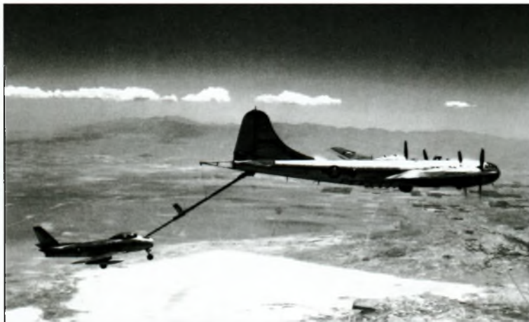
Отработка методики дозаправки в воздухе самолета F-86A Sabre от танкера B-29. Для уравнивания скоростей самолетов пилоту истребителя приходится выполнять полет на увеличенных углах атаки
