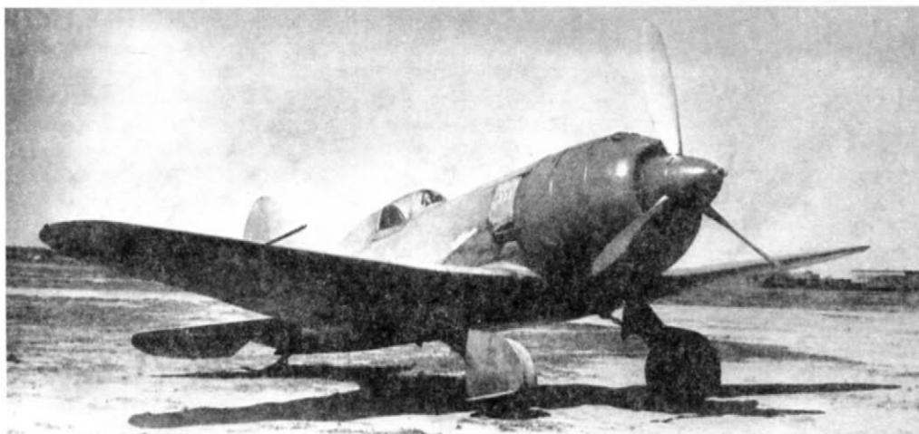
И-180-3 во время испытаний весной 1940 г. На самолете уже установлен сдвижной фонарь летчика
