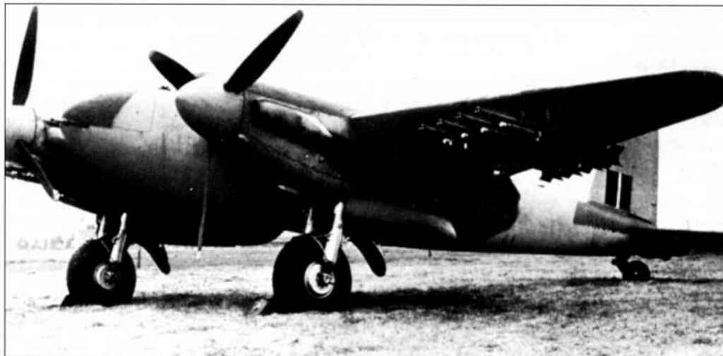
Подвеска реактивных снарядов впервые была опробована на истребителе-бомбардировщике «Москито» FB. Mk. VI заводской номер HJ719. Впоследствии «Москито» с ракетным вооружением нашли наиболее широкое применение в эскадрильях Берегового командования, атаковавших небольшие надводные корабли и подводные лодки
