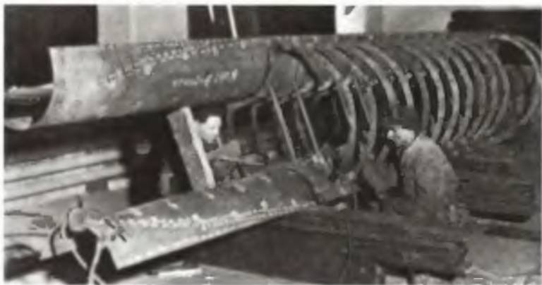
СМПЛ «Адам» — прототип «Бибера». Постройка лодки на заводе «Флендерверке» в Любеке (вверху) и ее испытания на плаву (справа)
