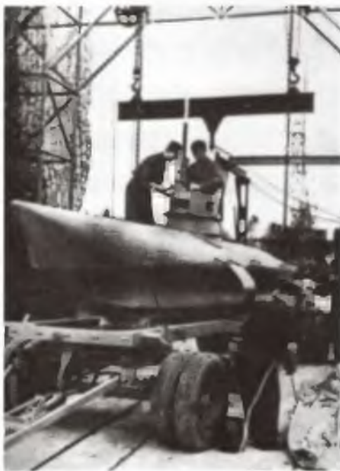
Окончательный монтаж СМПЛ типа «Бибер» на заводе-изготовителе
