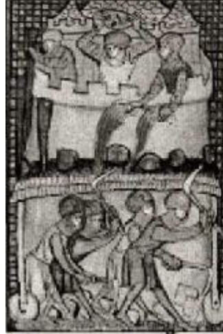
Рис. 85. Разрушение стены под прикрытием черепahi
