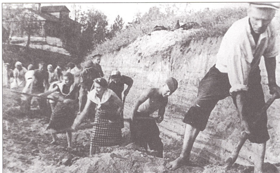
Ленинградцы создают новый оборонительный рубеж
