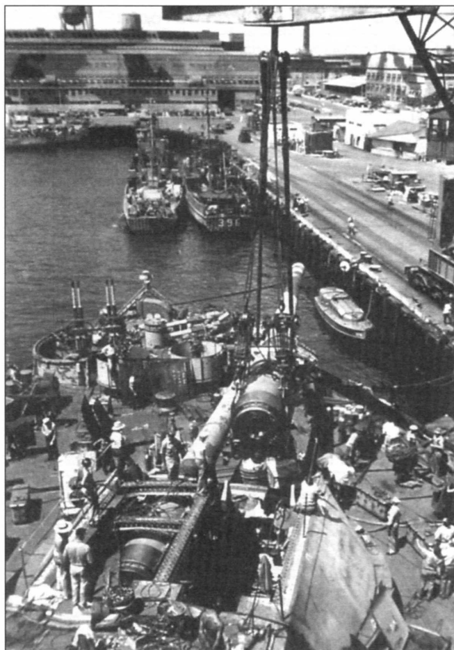
«Нью-Йорк» в Пёрл-Харборе: замена орудийных стволов (слева) и погрузка боезапаса (справа), июнь-июль 1945 г.
