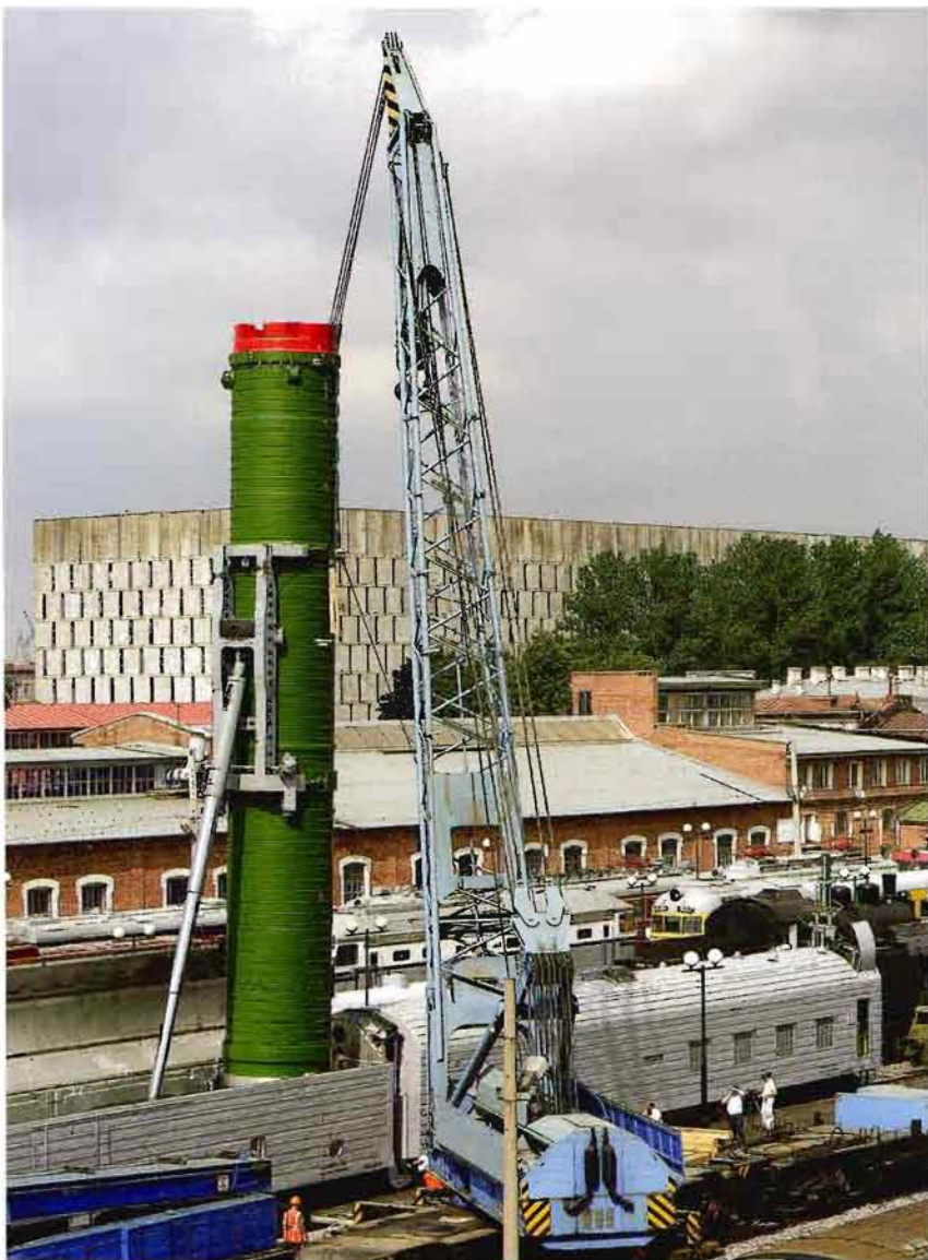
Установка транспортно-пускового контейнера
