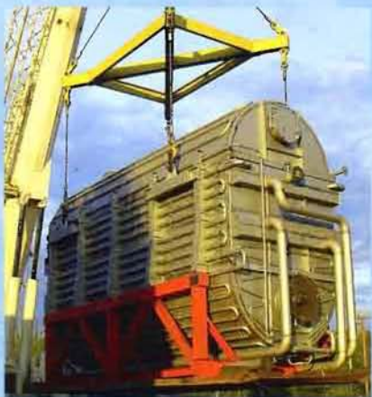
Конденсатор намораживания фталевого ангидрида
