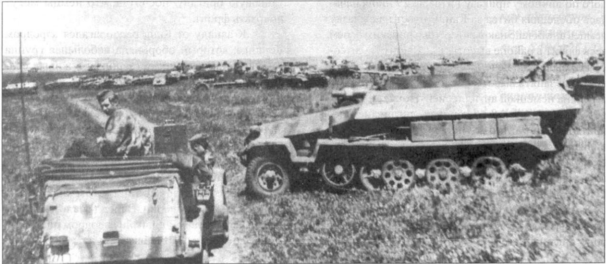
Бронетехника танковой дивизии подготовлена к контратаке. На переднем плане - SdKfz 251/9 с 75-мм пушкой. Эта пушка единична с той, что использовалась на ранних модификациях самоходных орудий StuG III.
