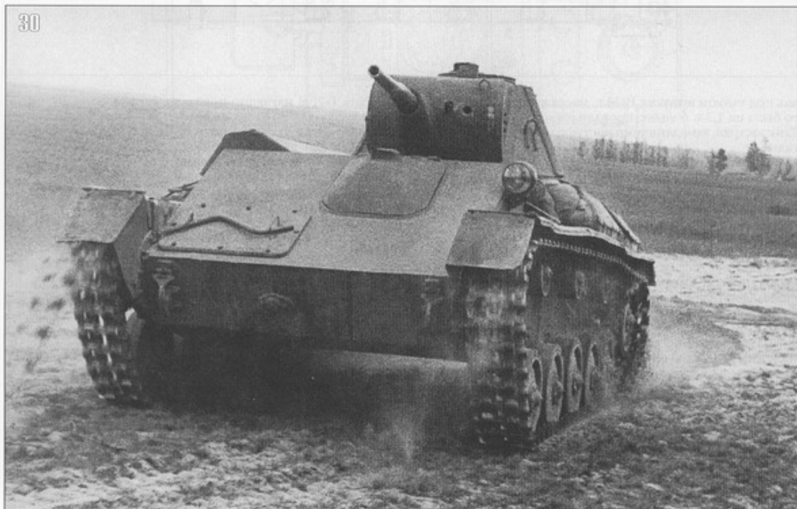
29, 30. Фото одного и того же Т-70М, сделанные на 1-м Белорусском фронте летом 1944 года. Хорошо видны ящики ЗИП на левом борту и укладка рукоятки для запуска двигателя на лобовом листе корпуса (АСКМ).
