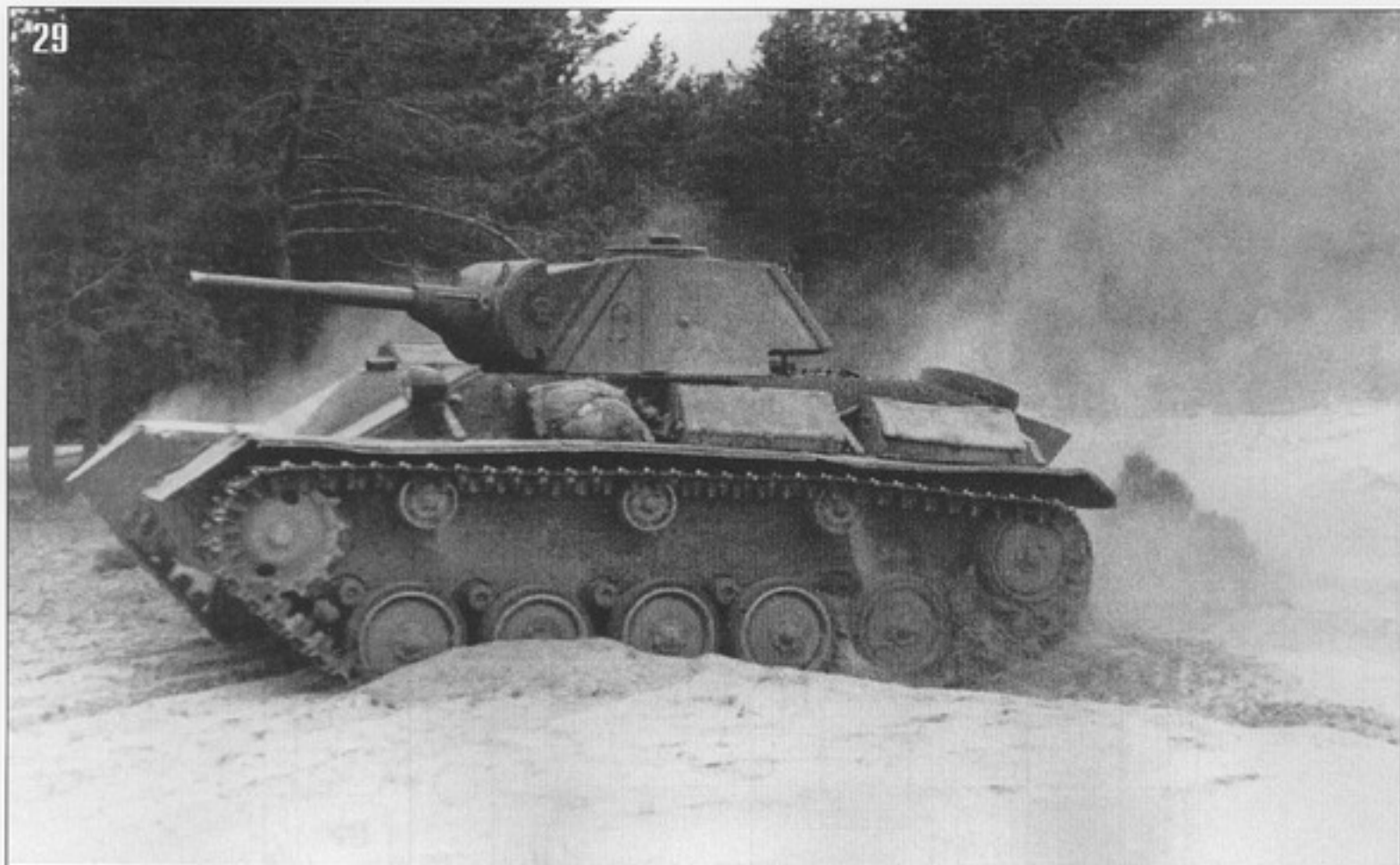
29, 30. Фото одного и того же Т-70М, сделанные на 1-м Белорусском фронте летом 1944 года. Хорошо видны ящики ЗИП на левом борту и укладка рукоятки для запуска двигателя на лобовом листе корпуса (АСКМ).
