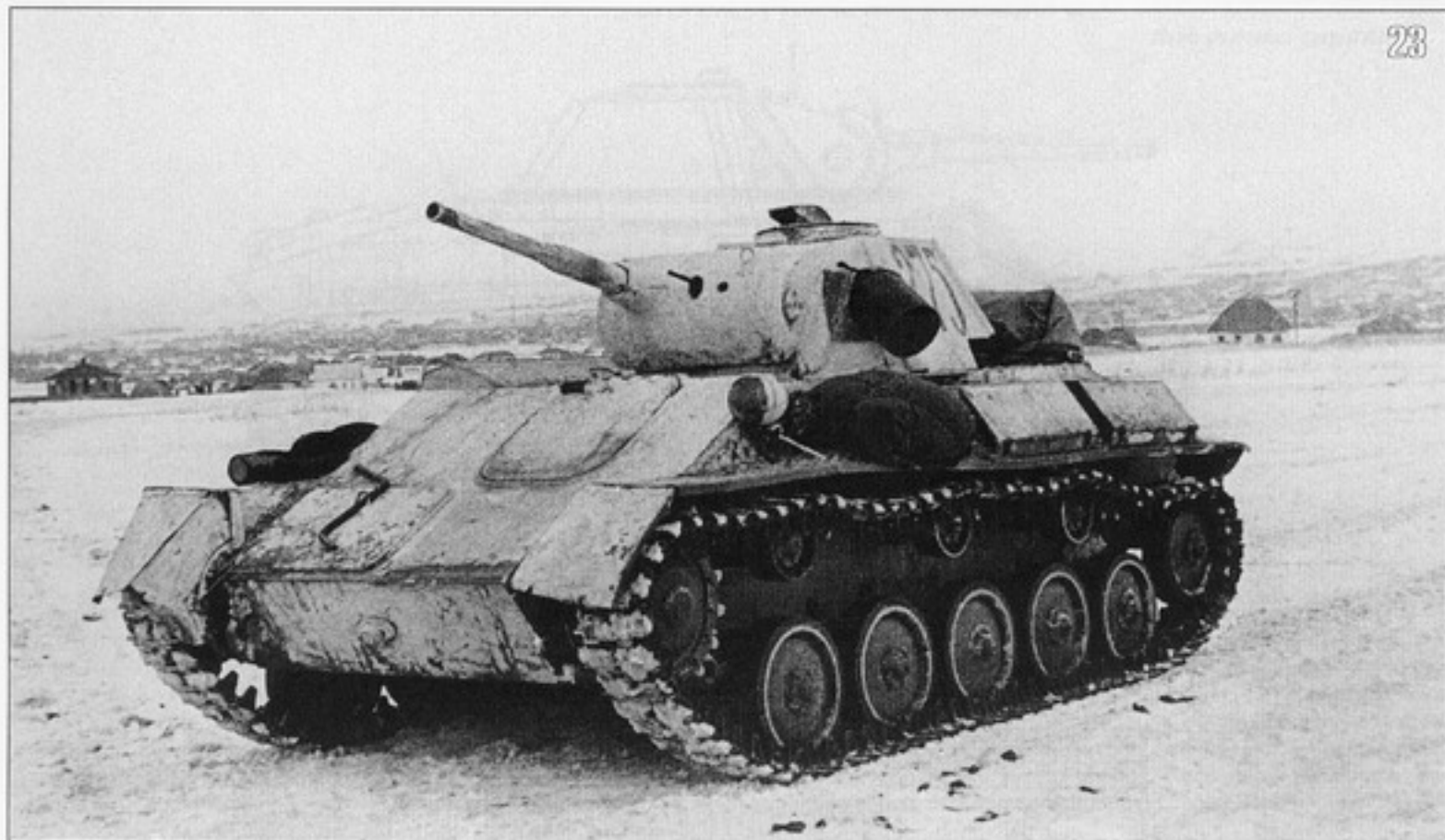
23. Танк Т-70М на марше. Район среднего Дона, декабрь 1942 года. Машина имеет зимний камуфляж с башенным номером 275, на лобовом листе корпуса лежит рукоятка для запуска двигателя вручную. Первые серийные танки Т-70М были отправлены в части Красной Армии, ведущей наступление под Сталинградом (РГАКФД).
