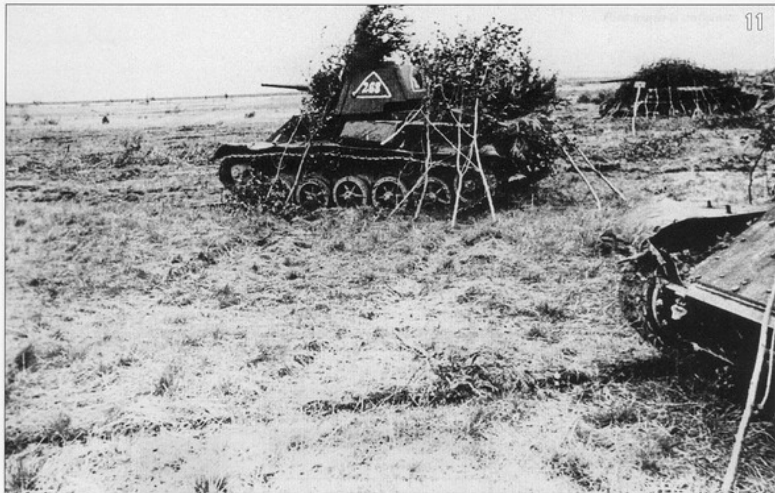
11, 12. Танки старшего лейтенанта Ф. Рубикина перед боем. Калининский фронт, лето 1943 года. На фото изображены Т-70 производства завода № 38 выпуска весны – начала лета 1942 года. Машины имеют литые опорные катки (РГАКФД).
